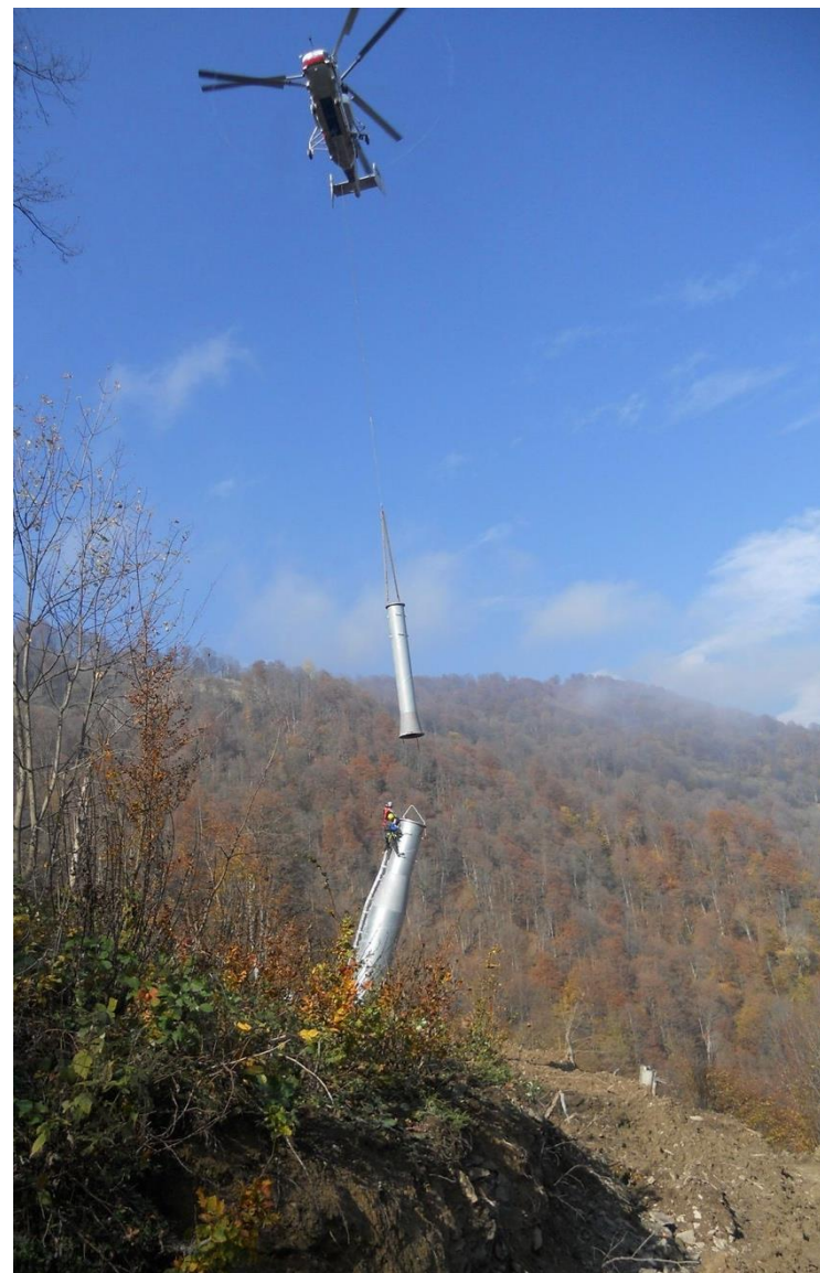
Чурочкин Александр «Монтаж канатки в горах Кавказа»
