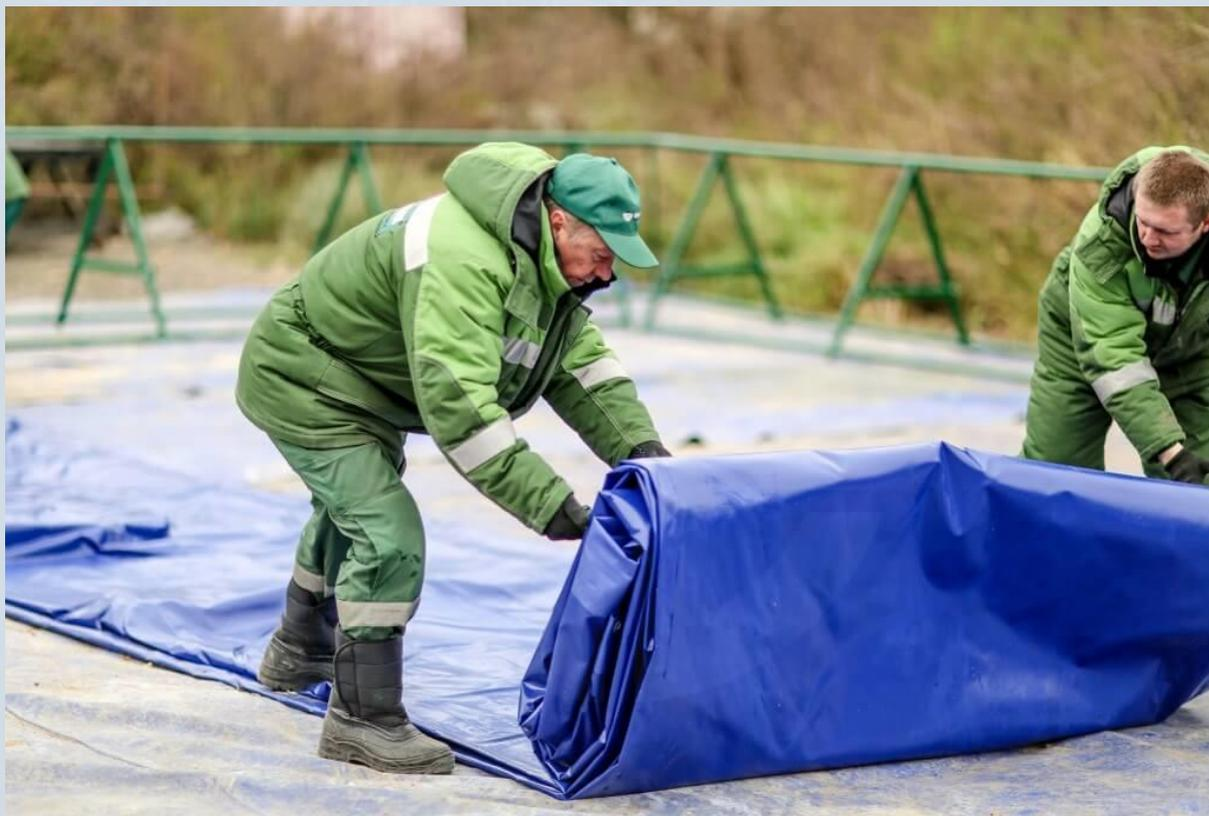
Время монтажа резервуара объемом 60 кубометров с защитным пологом силами 4 человек составляет около 5 часов
