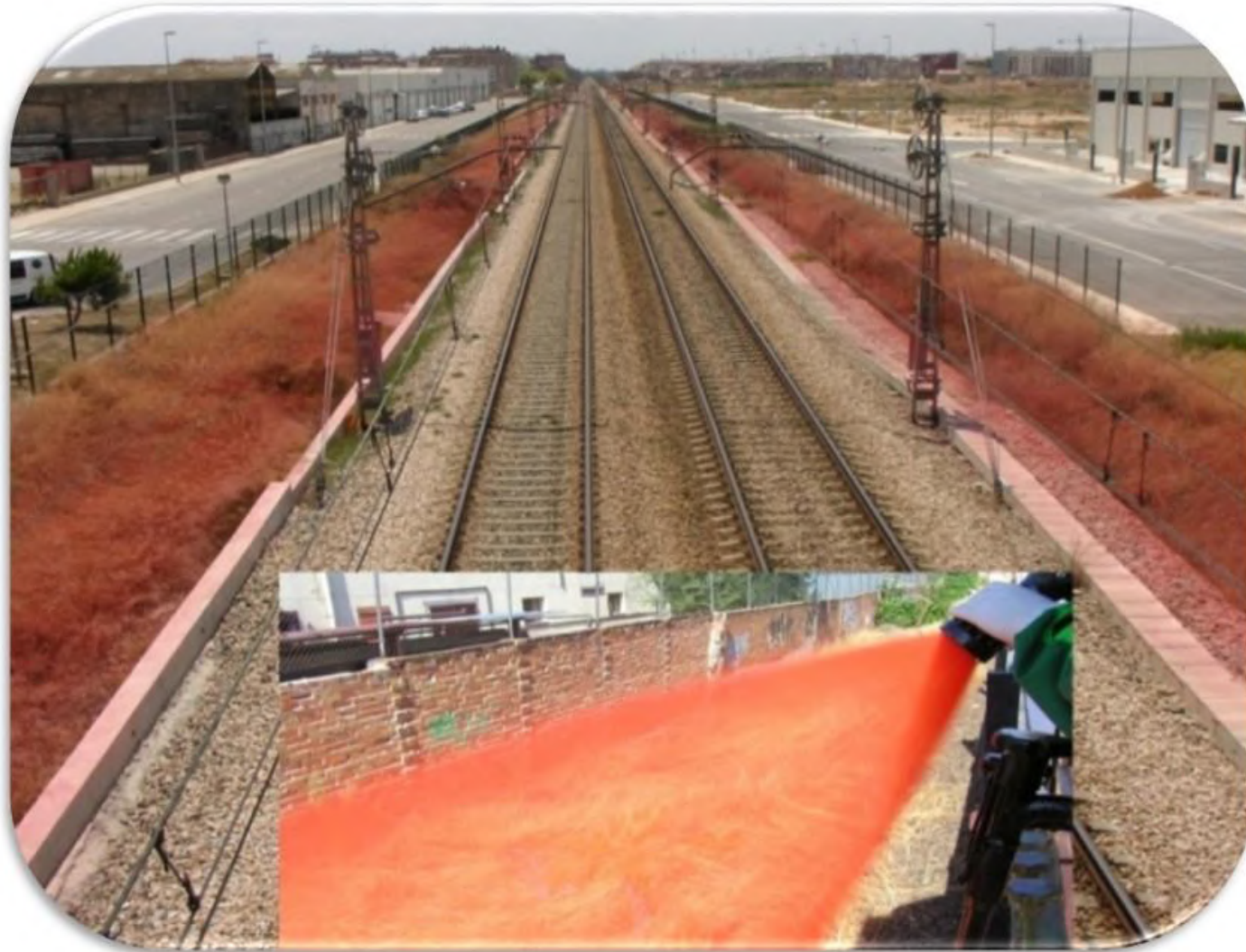
Обработка полос отвода железной дороги
