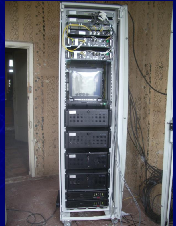
Радиооборудование АЗН-В режима 4, сервера, ЛККС
